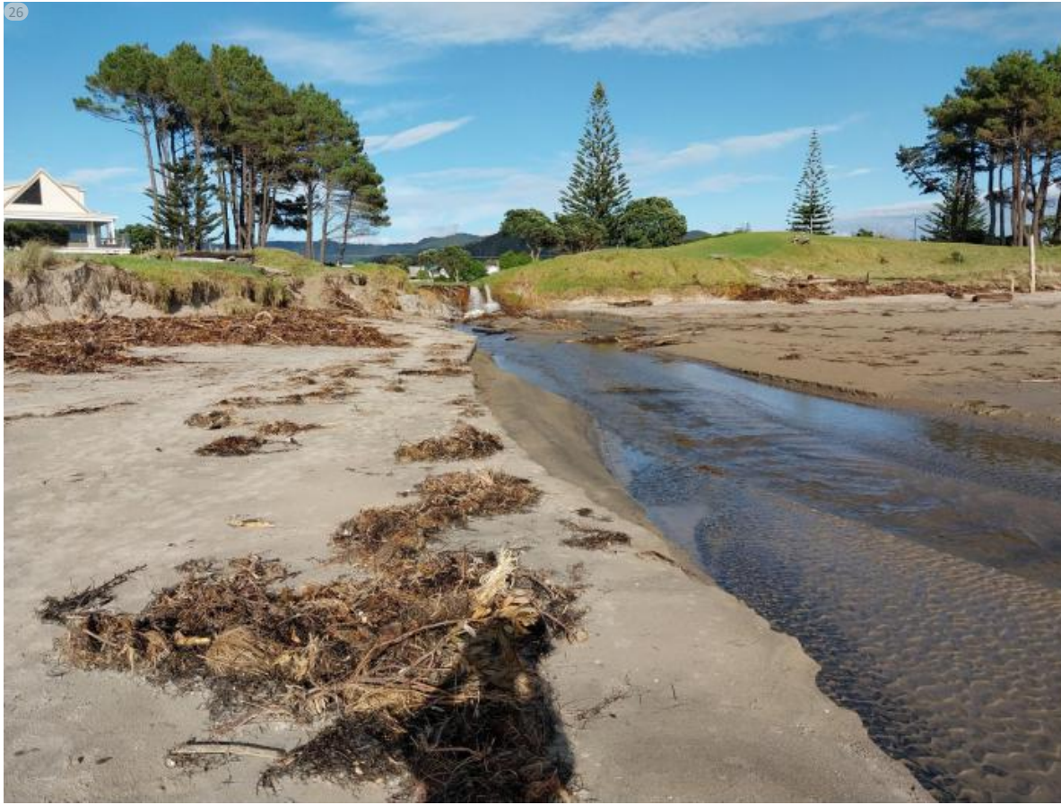
Williamson Lake Weir 20230228_090217.jpg
