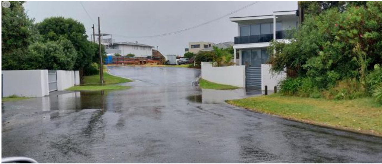
Mooloo Crescent flooding 20240222.jpg
